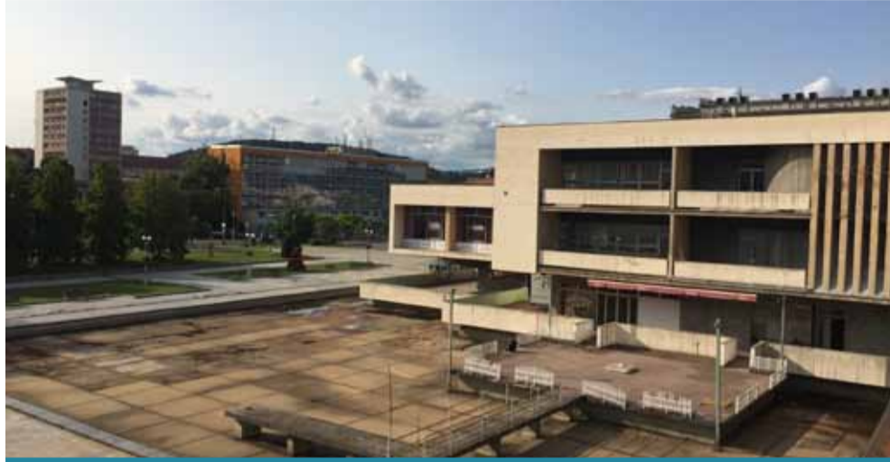
Rekonstrukce Repre je nejočekávanější a nejzásadnější akcí příštího roku.
