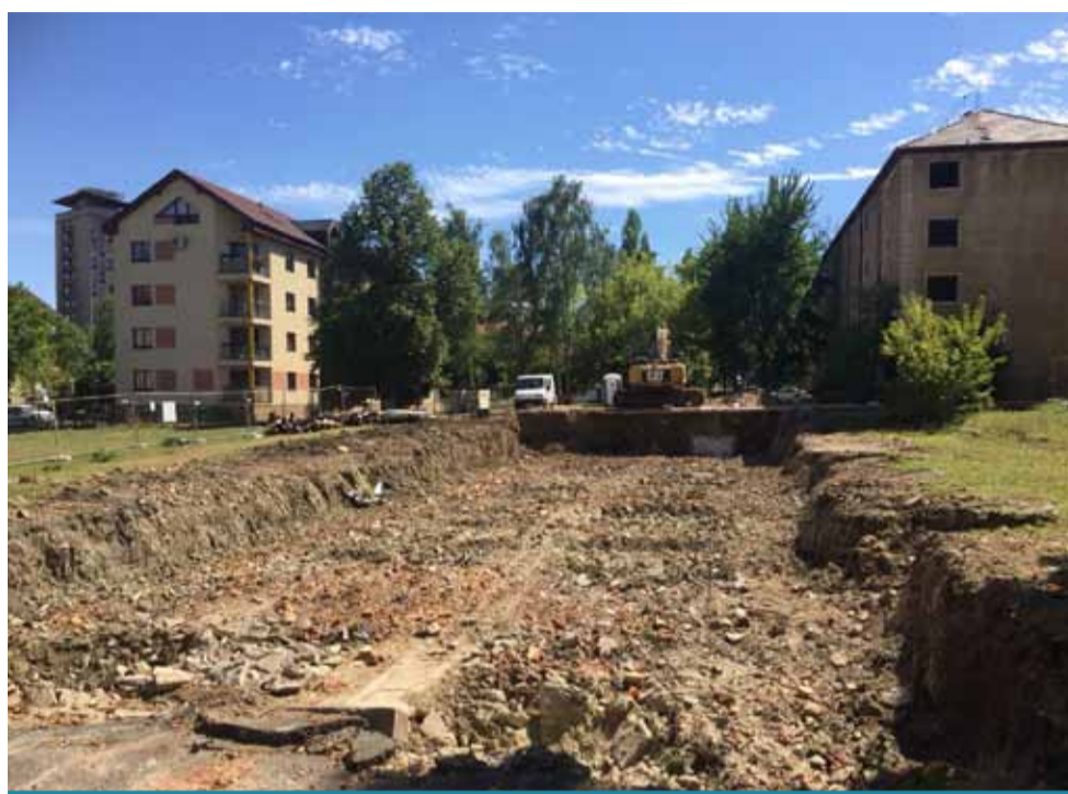
Po demolici domu zbyla díra. Zatím se zde s žádnou výstavbou nepočítá.
