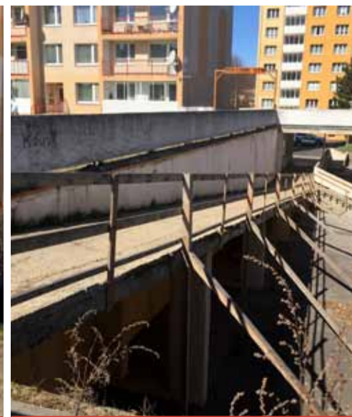
...a opraví se zrezivělá rampa.
