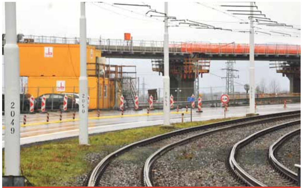
Práce na opravě mostu pod Hněvínem se snad již blíží ke zdárnému konci. Řidiči by si mohli oddechnout od objížďek v červenci.
