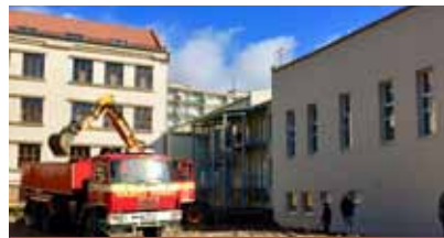
Stavební práce na rozšíření tělocvičny a vybudování jídelny provádí litvínovská firma YSSEN s.r.o.
