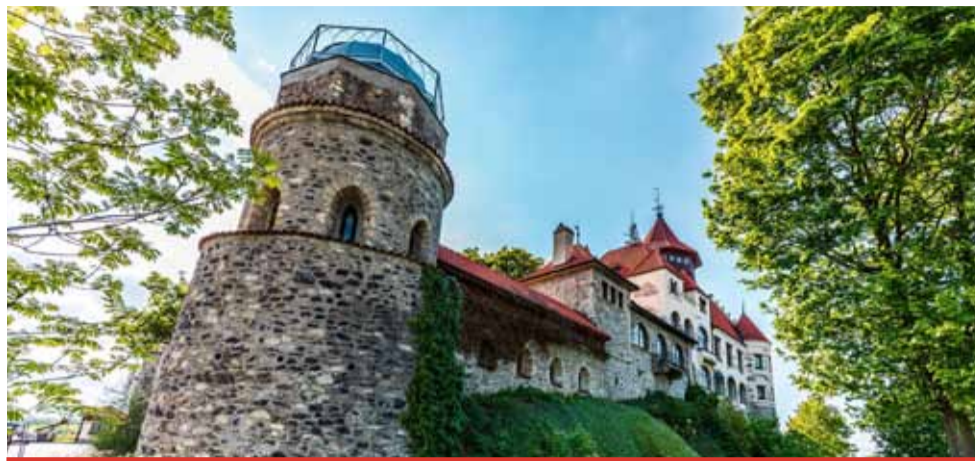
Hradby Hněvína se opravují na etapy, potrvají několik let.
