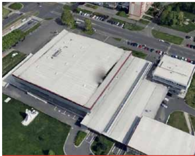
Oprava střechy vyřeší problém se zatékáním na všech místech kromě garáží.
