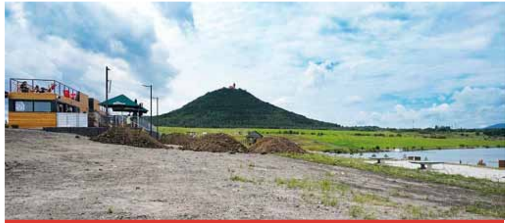
Navezená zemina, smíchaná s pískem bude sloužit jako podklad pro nové travní koberce. Ty budou technické služby pokládat v následujících čtrnácti dnech. Plocha pro relaxaci a opalování se tak zase o pěkný kus rozšíří.
