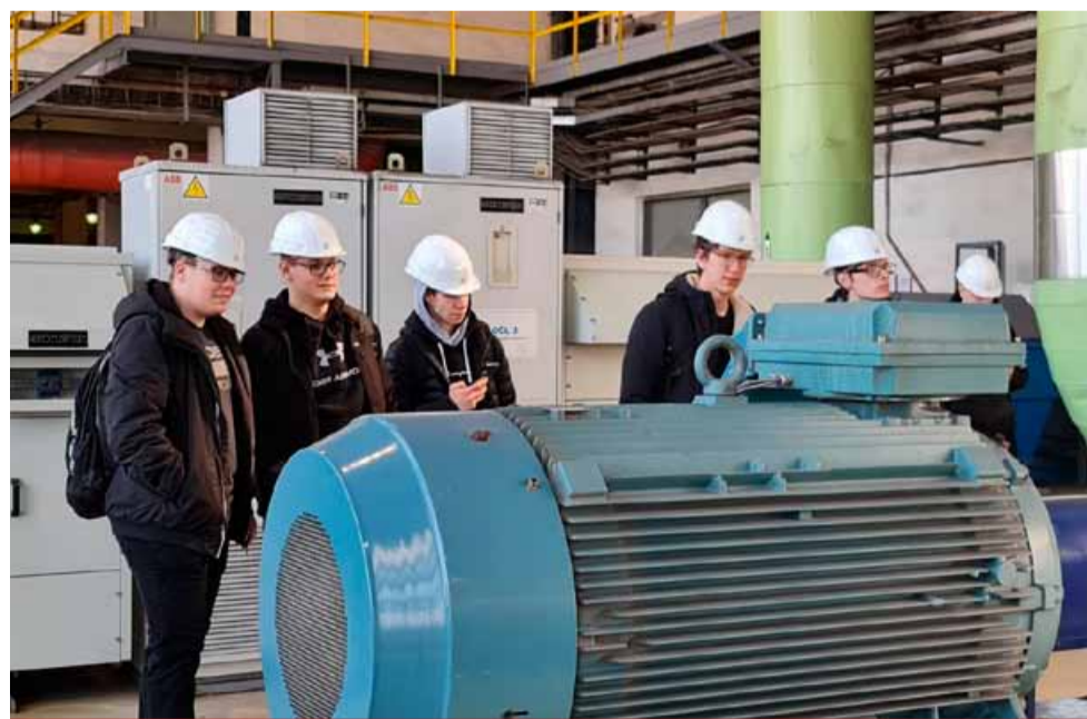
Prvními exkurzanty byli žáci třetího ročníku, obor Elektrikář, Střední školy technické ve Velebudicích.
