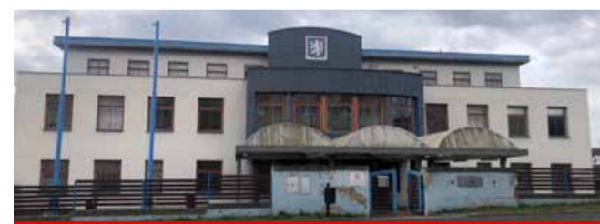
Než se policie přestěhuje do ulice Pionýrů, objekt se musí stavebně upravit.
