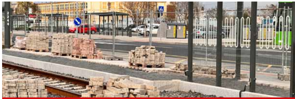
Důvodem rozebrání a rozkopání nově vybudovaného terminálu je špatná kabeláž, která se vyměňuje v rámci celého zrekonstruovaného úseku z Litvínova až do Záluží.
