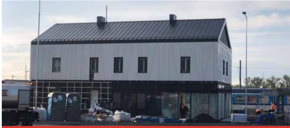
Součástí terminálu je také nová budova nádraží. Tu nyní modernizuje Správa železnic, a to zhruba do konce října. Cestující se konečně dočkají toalet a bezbariérového přístupu.
