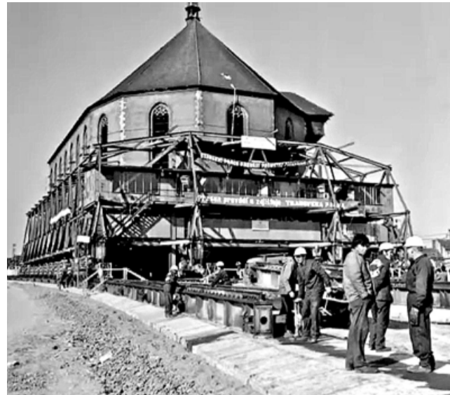
Unikátní přesun mosteckého děkanského chrámu je zapsán do Guinnessovy knihy rekordů jako přeprava nejtěžšího předmětu po kolejích. Jeho celková váha činila 12 tisíc tun.
