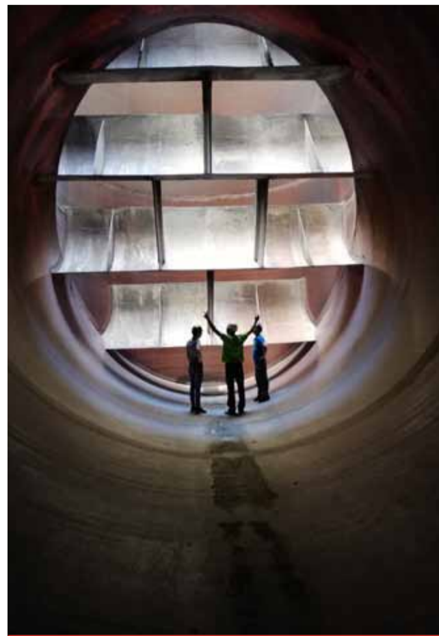
Vítězná fotografie z Elektrárny Chvaletice. Pořízena byla při jedinečné exkurzi do kouřovodu mezi absorberem a spalínovou věží. To, co připomíná plachetnici, jsou výstupní klapky z kouřovodu.
