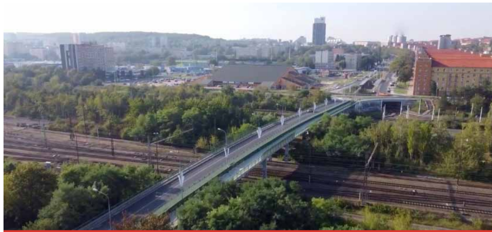
Pěší budou mít možnost chodit přes most ke kostelu přes vozovku a až bude lávka hotová, začne se s vozovkou a pěší budou chodit již po nové lávce. Pro ně zůstane pochozí most otevřený po celou dobu.
