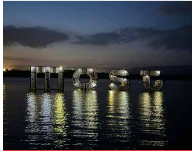
Opravený fotopoint je nově osvětlený, má dálkovou výstražnou signalizaci, zvýšila se tonáž jeho ukotvení a další opatření proti vandalům se ještě připravují.
