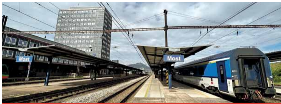
Až Správa železnic s úpravami mosteckého nádraží začne, počítá se i s rekonstrukcí nástupišť a kolejíště.
